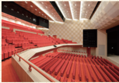
天井や壁には市松模様。布と木を組み合わせることで、音響的にも良い効果が得られているそう。
