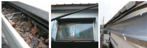
落ち葉がたまっている 完全に落ちている ゆがんでいる
