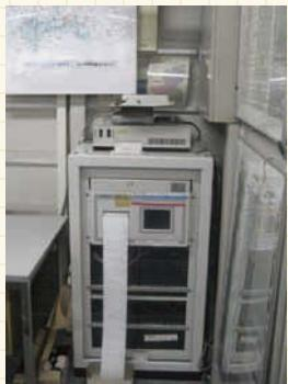
計測震度計(処理部)、地震計に記録
