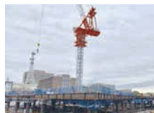
↑新庁舎の工事現場の様子
