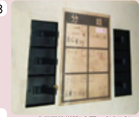
エアコン専用回路増設・変更工事もお任せ
