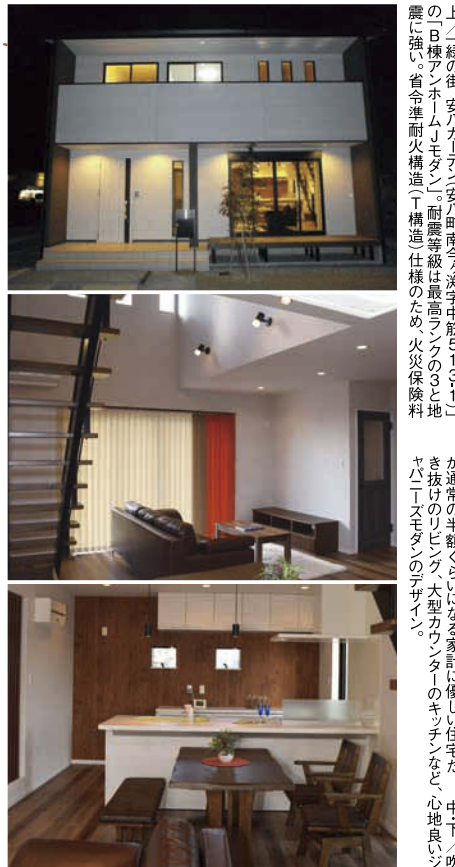
上/「緑の街 安八ガーデン(安八町南今ヶ淵中筋513-1)」の「B棟」は、ホームJマスター。耐震等級は最高レベルの3と地震に強い。省令準耐火構造「構造」仕様のため、火災保険料が通常の半額くらいになる家計に優しい住宅だ。中下/吹き抜けのリビング。大型カウターのキッチンなど、心地良し。キッチンマスターのデザイン。
