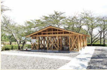
【バーベキューガーデンA・B・C・D】電気があるので夜のバーベキューも可。
