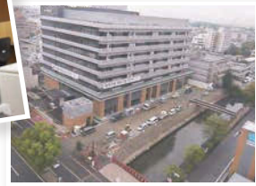
↓旧庁舎の北側に建てられた新庁舎。手前に流れるのが水門川。
