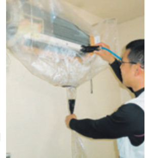
手作業では難しい奥の汚れも機械で徹底洗浄!
